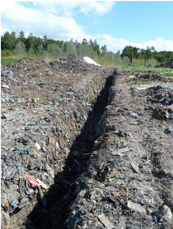
Fotodokumentation Gaserfassung Deponie Konstanz Dorfweiher
