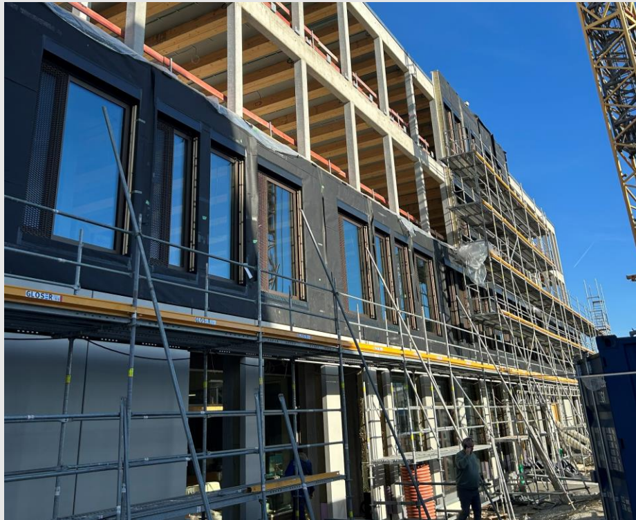
Fassade ZG: Montage der Holzfassade in vorgefertigten Modulen
