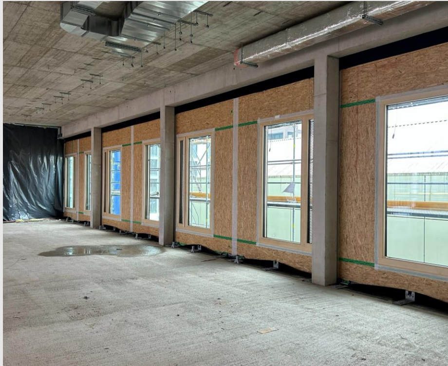
GT2: Gebäudehülle ist geschlossen (hier Holzfassade im 1. OG)
