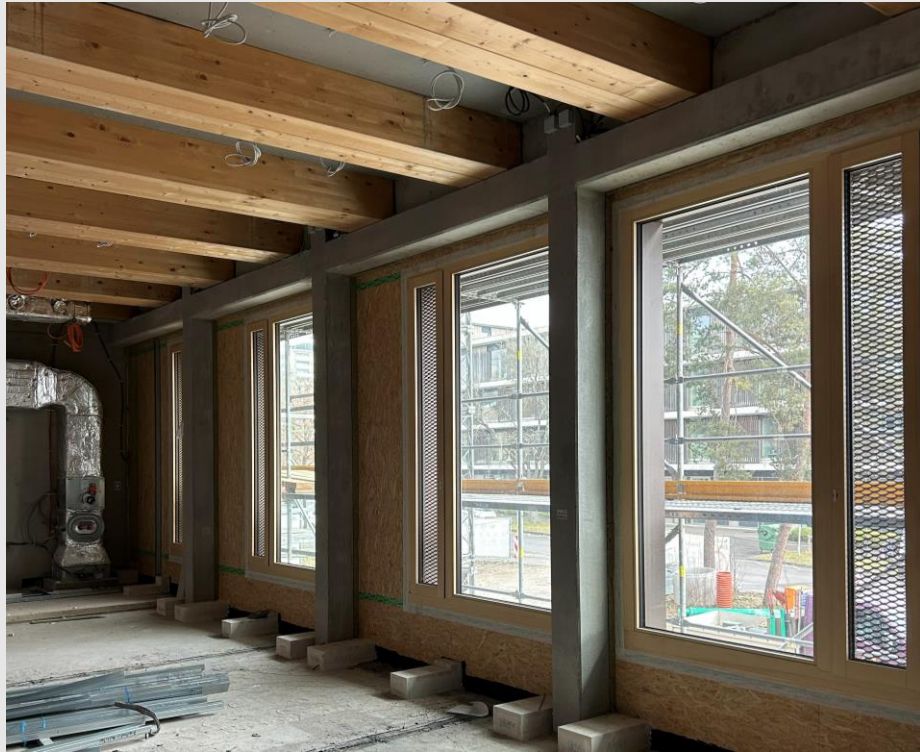
ZG: HBV-Decken (Holz-/Betonfertigteile) und Fassadenmodule
