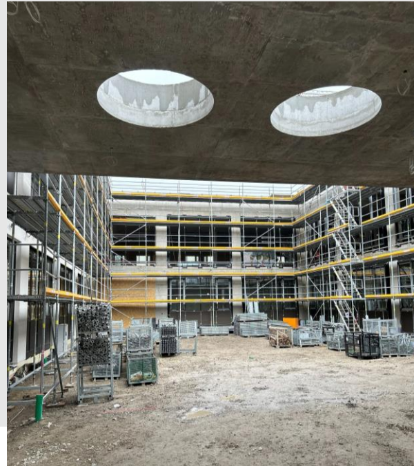
GT2: Flugdach im Innenhof GT
