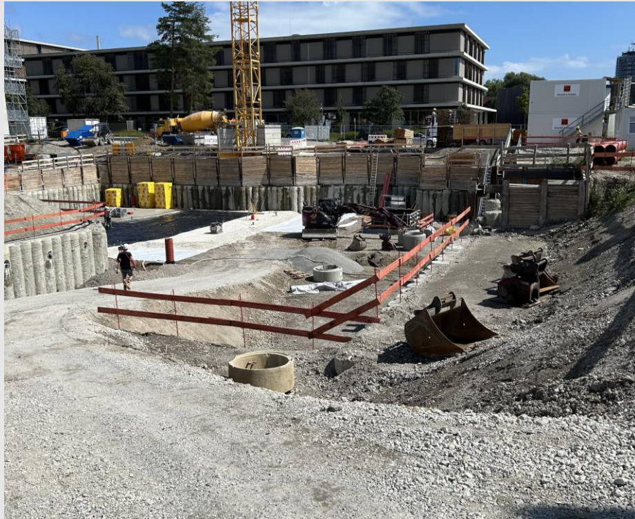
Rohbauarbeiten ZG: Start Betonage Bodenplatte UG
