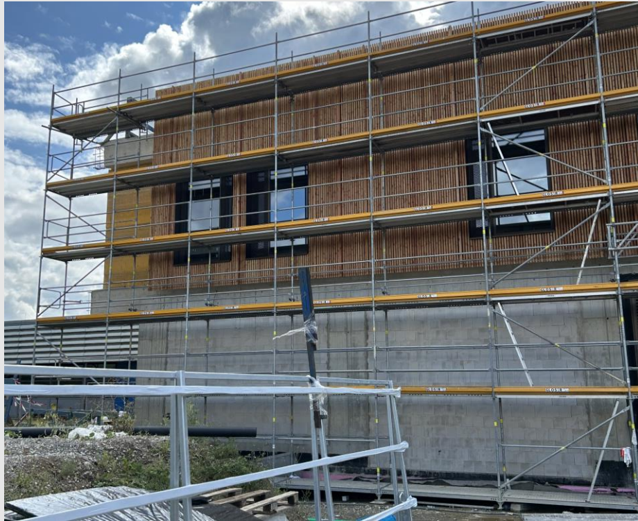
GT1 Anteil Holzfassade mit Holz-Alu-Fenster
