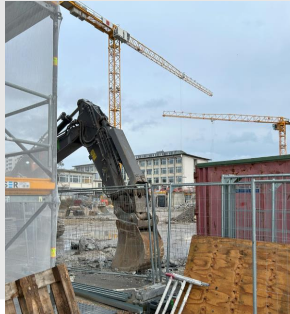
GT2 Blick auf Bestandsbau B
