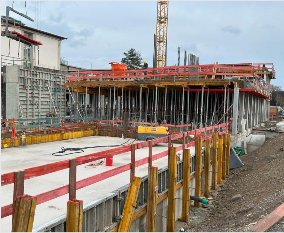
Rohbauarbeiten ZG: Rest Rohbau EG, in Teilen Start 1. OG
