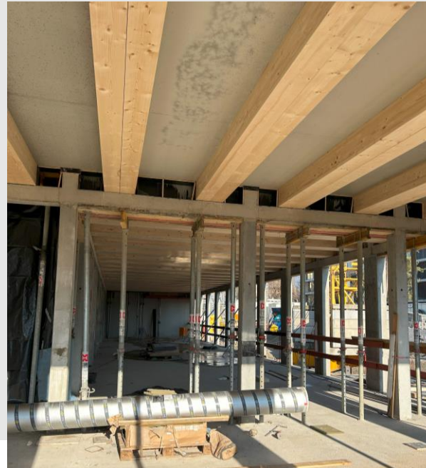
ZG: Holz-Verbund-Decken auf Stahlbeton-Stützen
